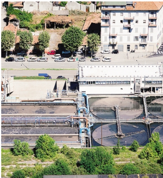
L'impianto di depurazione di viale Innocenzo
